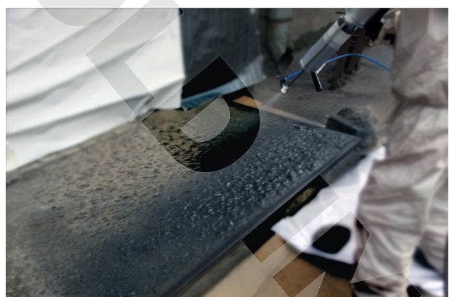
Через пару секунд, опустите оборудование и направьте ‘факел’ распыления в сторону или вниз (для этого, можно заранее повесить на стене большой лист бумаги или положить на полу несколько листов газеты), и распыляйте эластомерный материал еще в течение 3-5 секунд. Это позволит удалить воздушные пузыри в верхней части картриджа и распылит начальные, возможно недостаточно хорошо смешанные, эластомерные компоненты.
