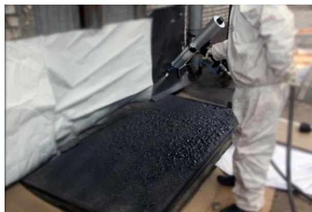
Для увеличения толщины слоя, после нанесения эластомерного покрытия на площадь 2-3 квадратных метра, вернитесь в исходную точку и повторно нанесите слой эластомерного материала на этот участок поверхности. Нанесение эластомерного покрытия тонкими слоями является более предпочтительным и позволяет избежать образования подтеков на вертикальных участках поверхности.
